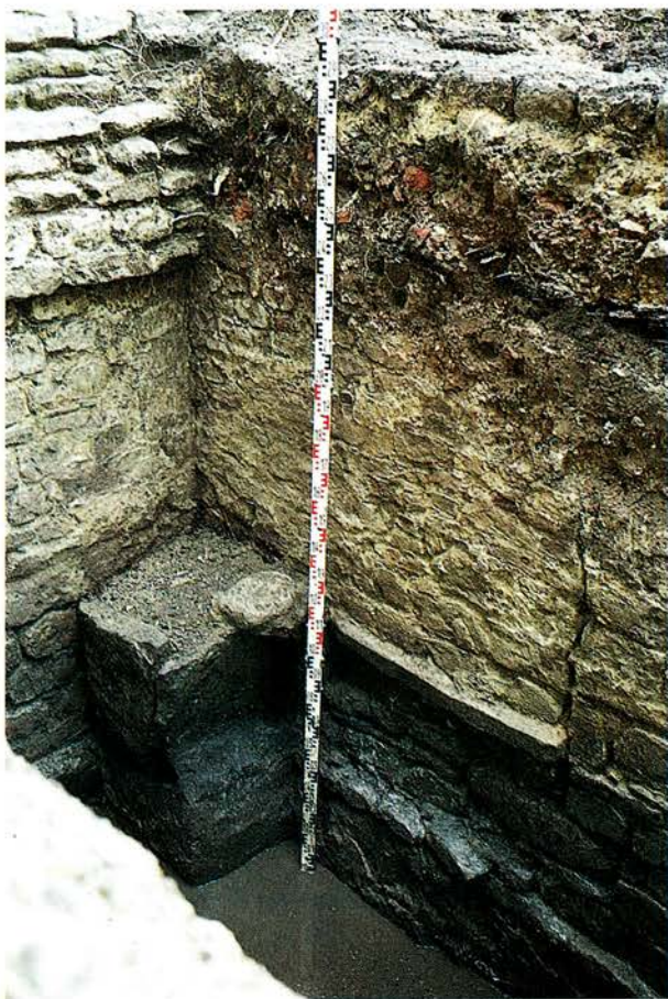
50. Opgravingen van het Slot : zicht op de bekisting van de fundering gesitueerd in de hoek van de muren 2 en 3 (foto Fr. JURION, 1984).
