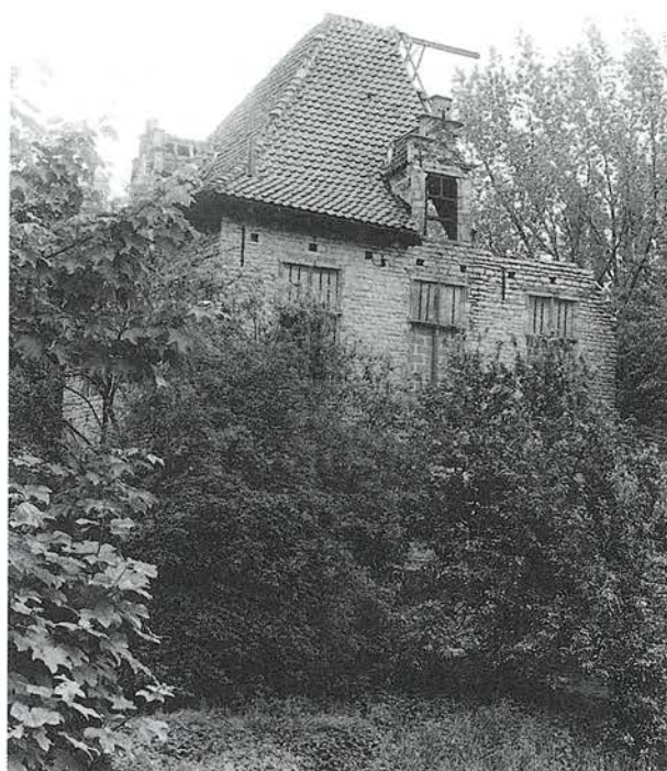
47. Het Slot in 1984 voor de opgravingen en de restauratiewerken (foto Fr. JURION, 1984).
