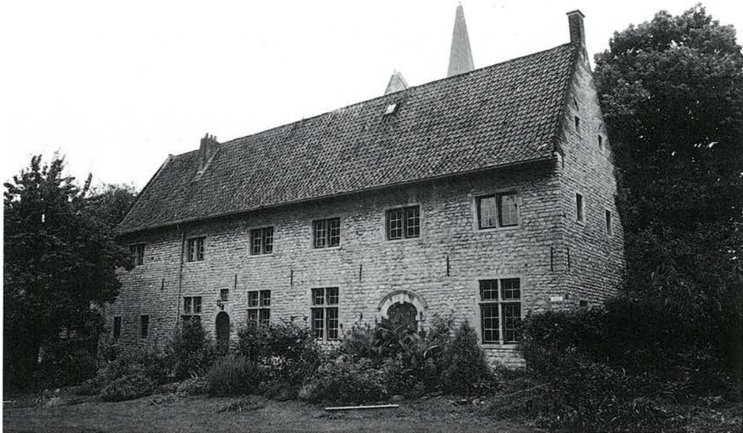
45. Zicht op het gerestaureerde gebouw van de oude aangebouwd tegen de Lenneke Marekapel (foto A. de VILLE de GOYET, 1992).
