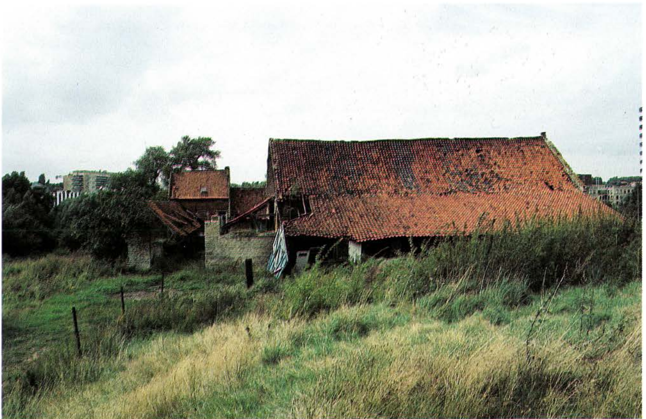
40. Zicht op de schuur en de ingang van het hof ter Musschen (foto Y. CABUY, 1992).
